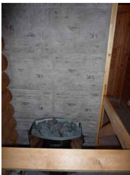
Hoppussa tehtiin pesu- ja saunatilojen peruskorjaus.
